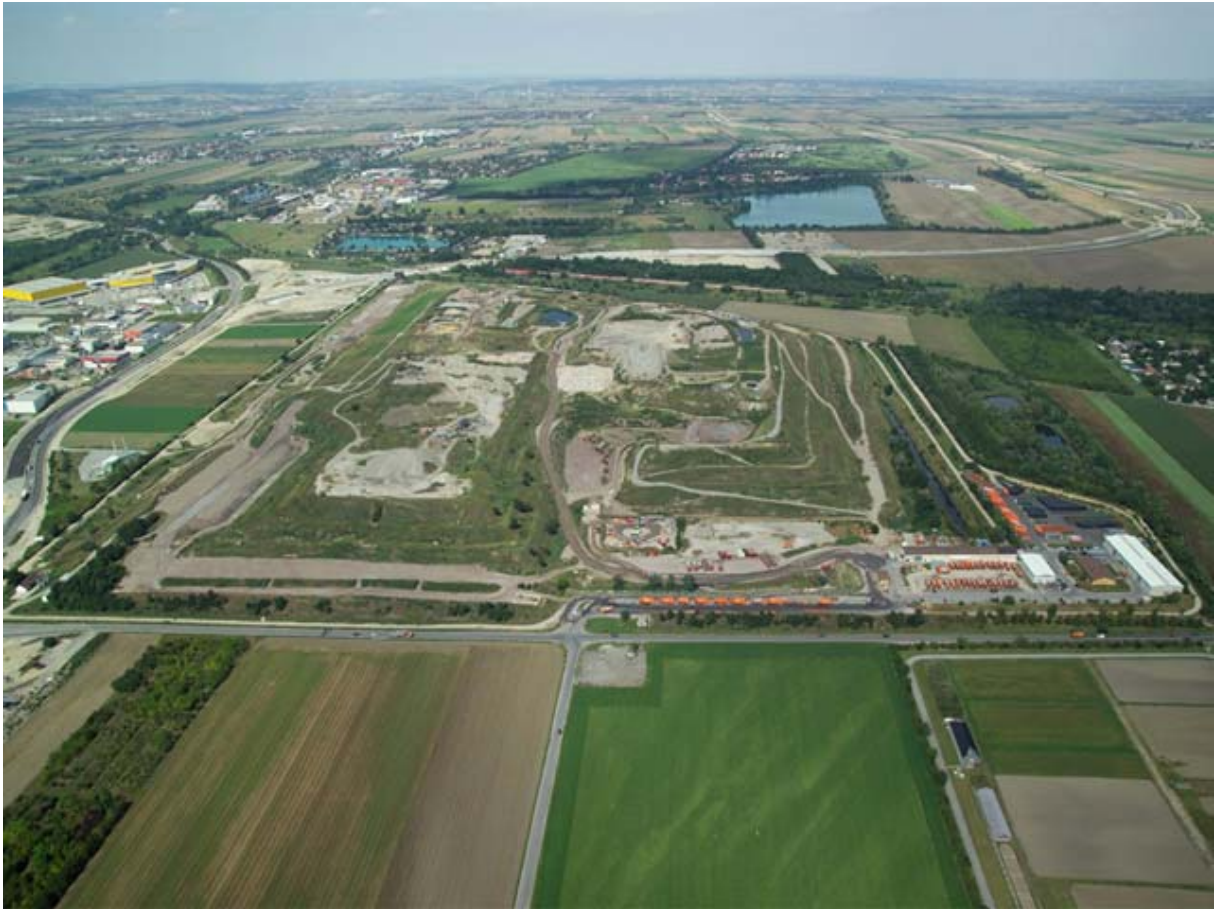
Abbildung 1: Luftbildaufnahme Deponie (Foto: Bestand Öko-Institut)
