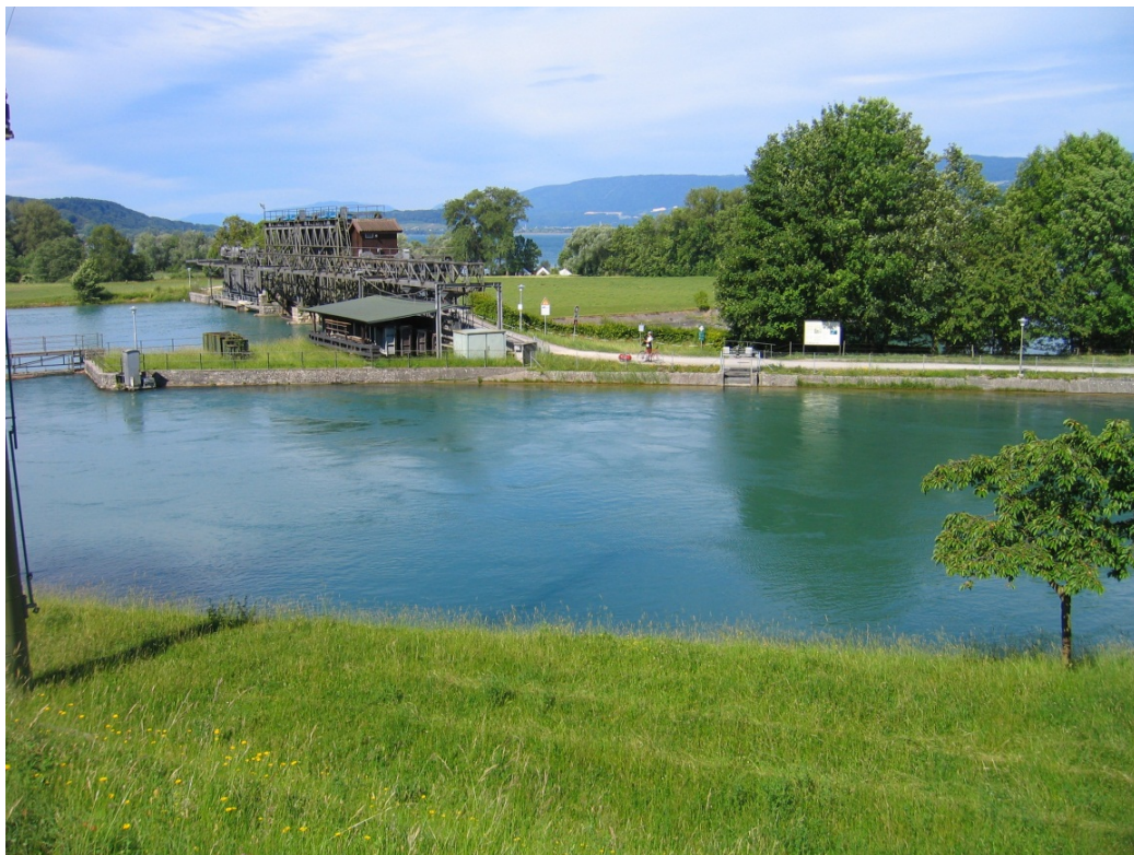
Abbildung 3-3: Stauwehr am Eintritt der Aare in den Bielersee
