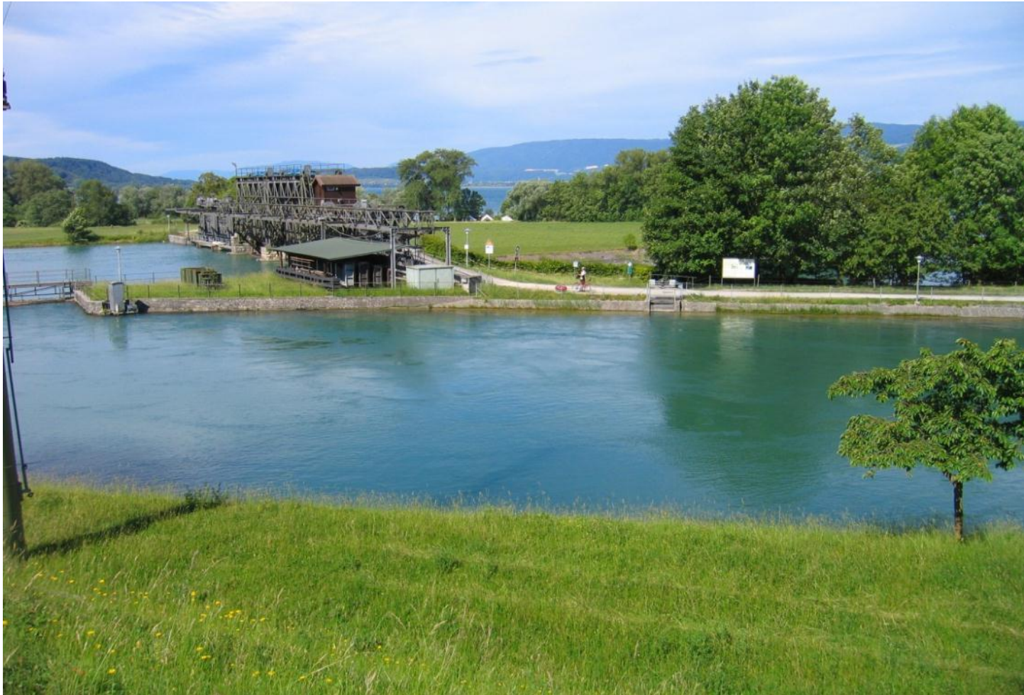
Stauwehr zwischen Aare/Hagneckkanal und Bielersee
