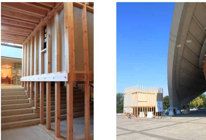
Abbildung 9: Die Konstruktion von imbaueinbau aus märkischer Kiefer [Fotos: M. Schmied]
