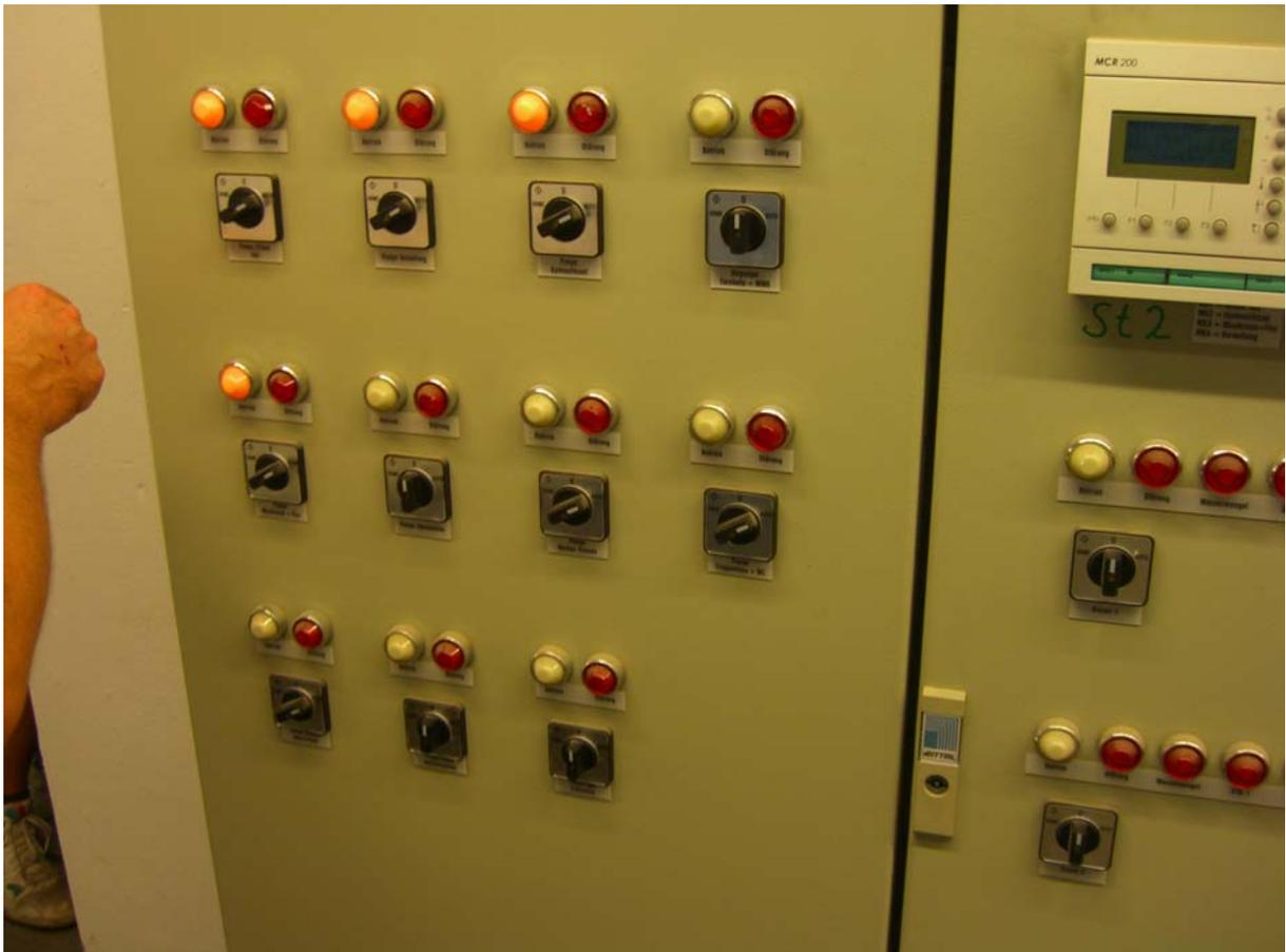
Abbildung 31 Steuerungstableau für die Heizungsanlage in Haus 5 der Brüder-Grimm-Schule
