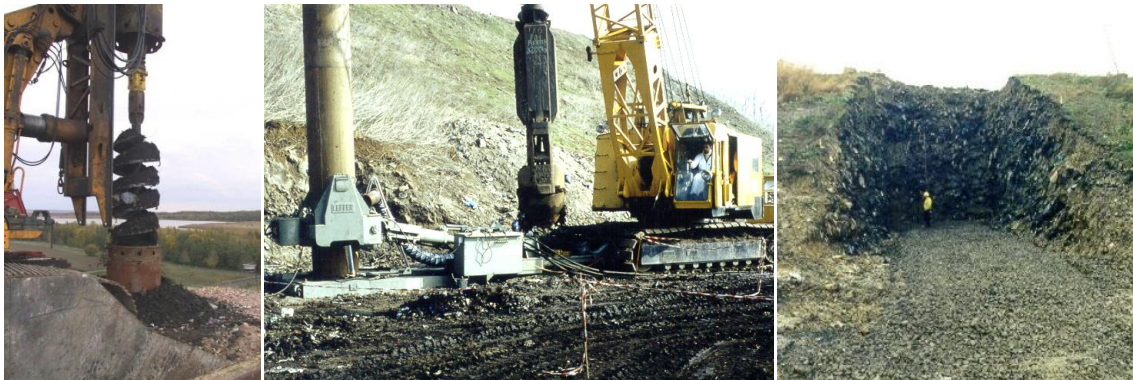
Abbildung 2-2: Schneckenbohrung, Greiferbohrung und Großschurf in Hausmülldeponien
