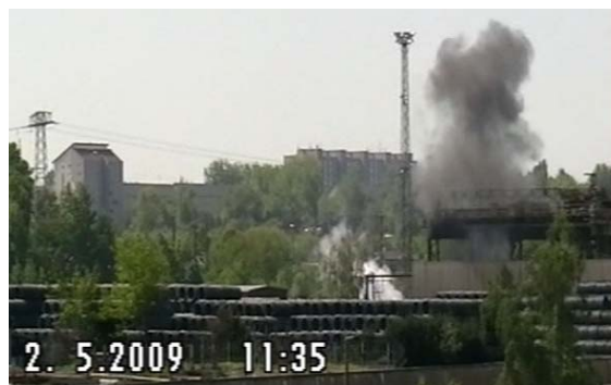
Abb. 4: Staubpilz, der beim Entladen von Schlacke im Fallwerk entsteht
