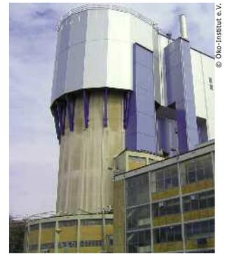
Der Versuchsreaktor AVR mit der an das Reaktorgebäude angebauten „Materialschleuse“, in der der Reaktorbehälter herausgehoben, gekippt und auf ein Fahrzeug zum Abtransport verladen werden soll.
