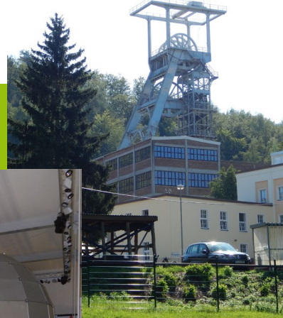
Schacht 371 in Hartenstein (Lampke 2024)
