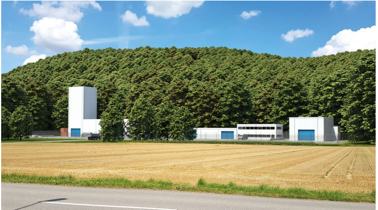
Abbildung 6: Kombinierte Nebenzugangsanlage für Betrieb (linkes Gebäude: Schachtzugang, Materialtransport) und Lüftung/Bewetterung (rechtes Gebäude) (Nagra 2021)
