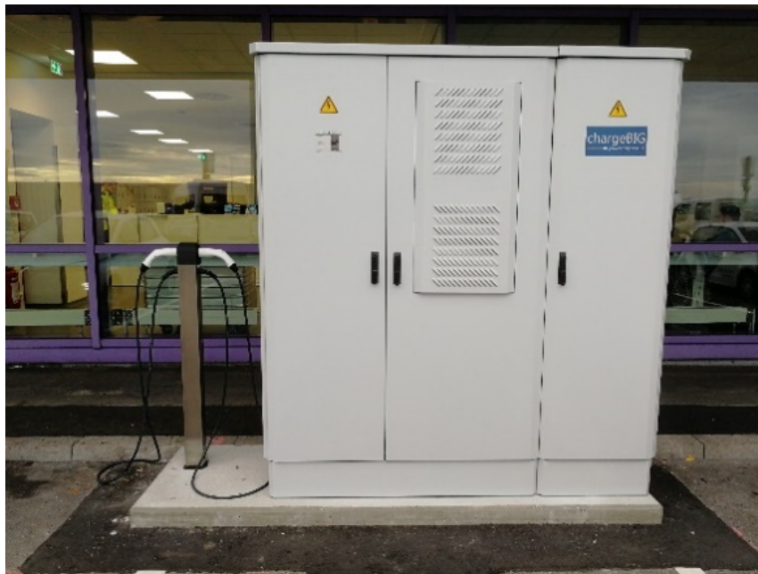
Abbildung 2-10: chargeBIG-Ladepunkt mit Umspanneinrichtung
