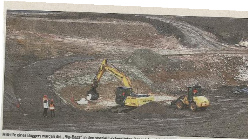
Mithilfe eines Baggers wurden die „Big-Bags“ in den speziell vorbereiteten Deponiebereich eingebaut.
