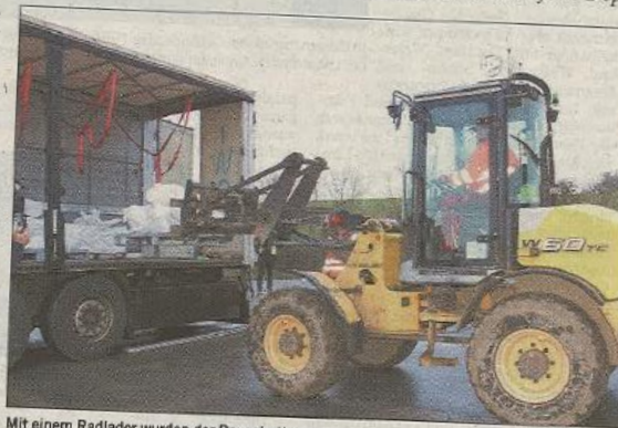
Mit einem Radlader wurden der Bauschutt aus dem Lkw genommen. Fotos: Tanja Radan
